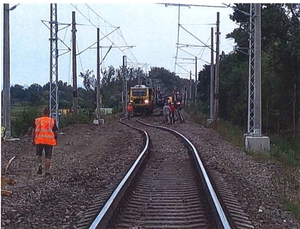
S-prepojenie – začiatok smerovej a výškovej úpravy GPK
