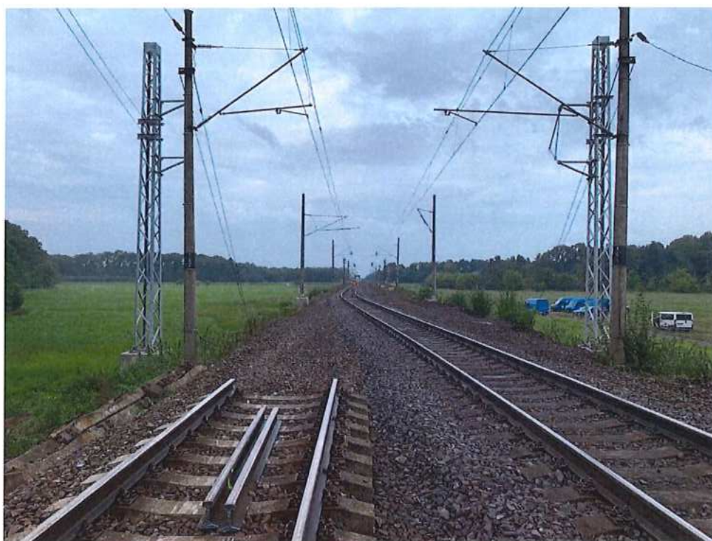
S-prepojenie po konečnej úprave GPK
