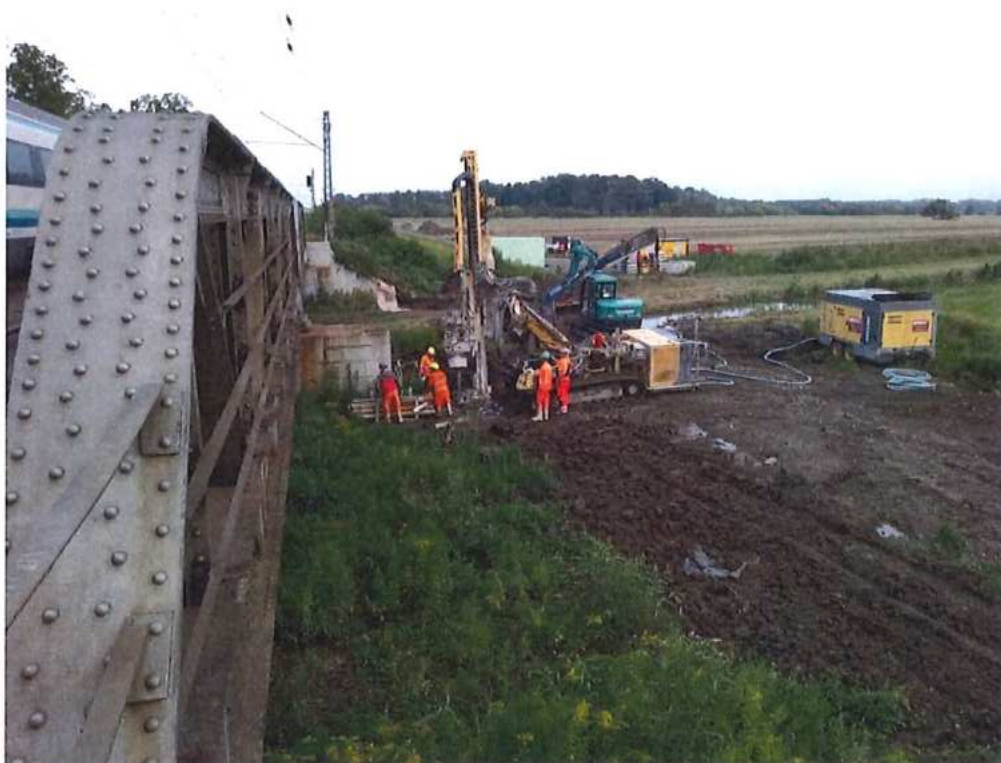
Spoločnosť KELLER – zakladanie - vŕtanie mikropilót v km 73,466
