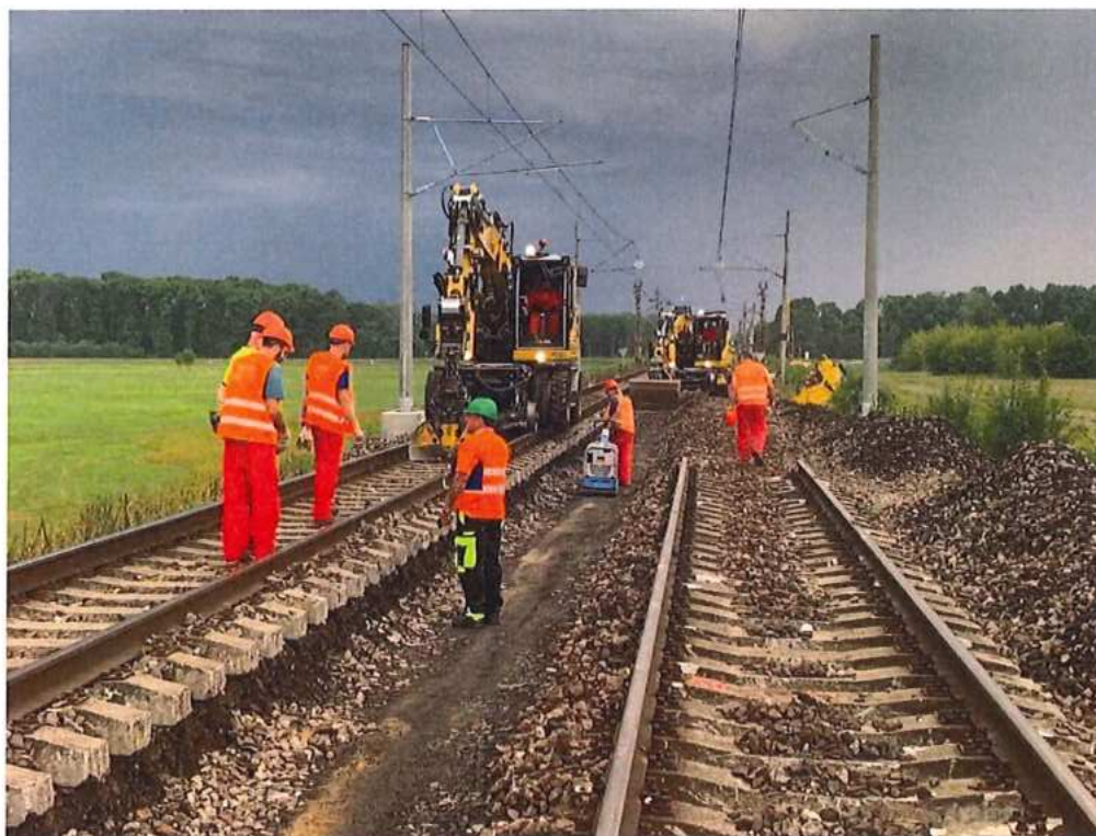
S-prepojenie – úprava pláne v osi os – odťazenie štrkového lôžka a zhutnenie pláne
