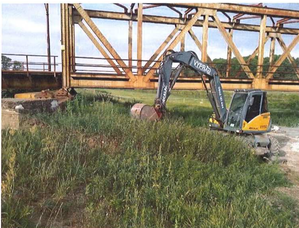
Úprava terénu pred zahájením vŕtania pilót pri opore číslo 1 v km 74,386
