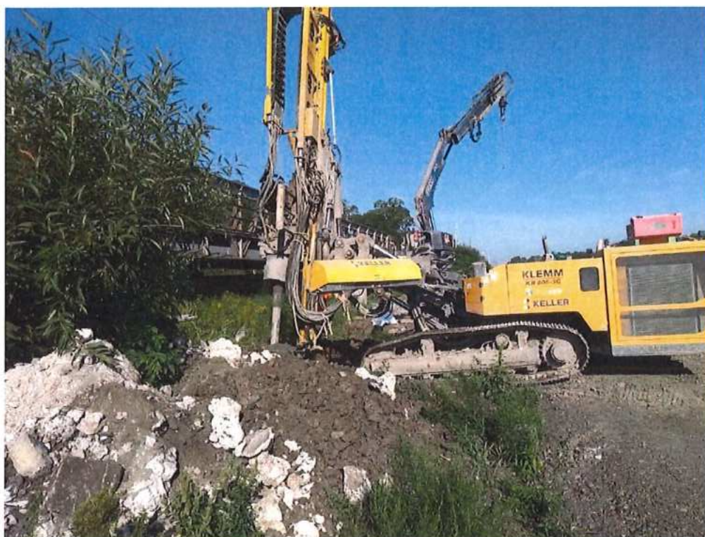
Spoločnosť KELLER pri zriaďovaní mikropilót v km 73,466 a 73,210
