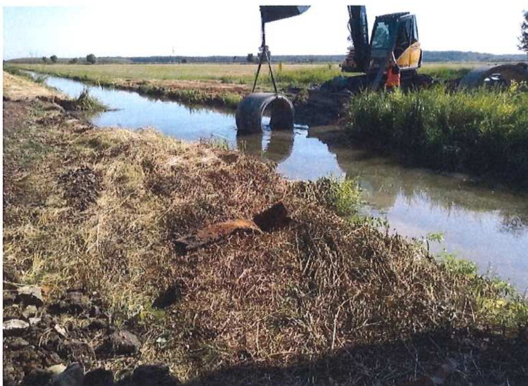
Zatrubnenie kanála pri moste v km 73,466
