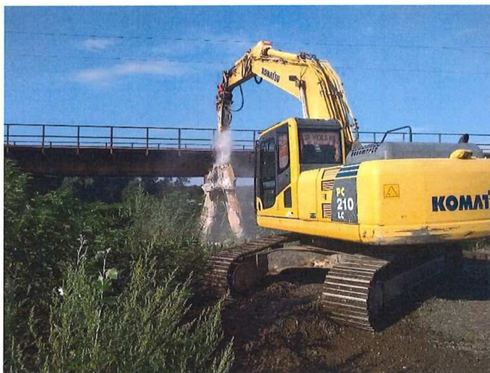
Demolácia opôr na predmostí v km 74,386
