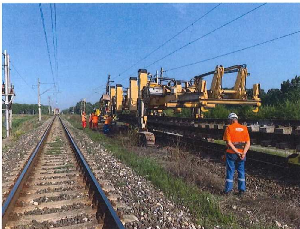
Spoločnosť TSS Grade - Demontáž a odvoz koľajového roštu 2.TK v km 73,850 – 74,250 strojom DESEC
