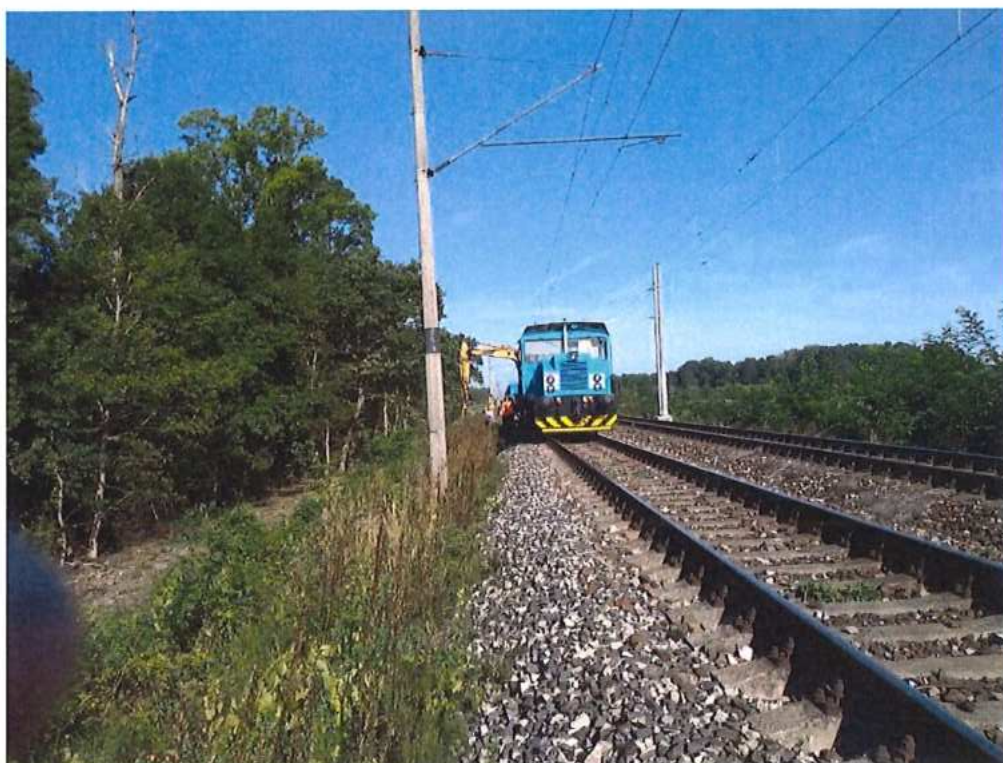
EŽ Praha pri zriaďovaní základov pre trakčné stožiare pri 1.TK na ÚČS 12
