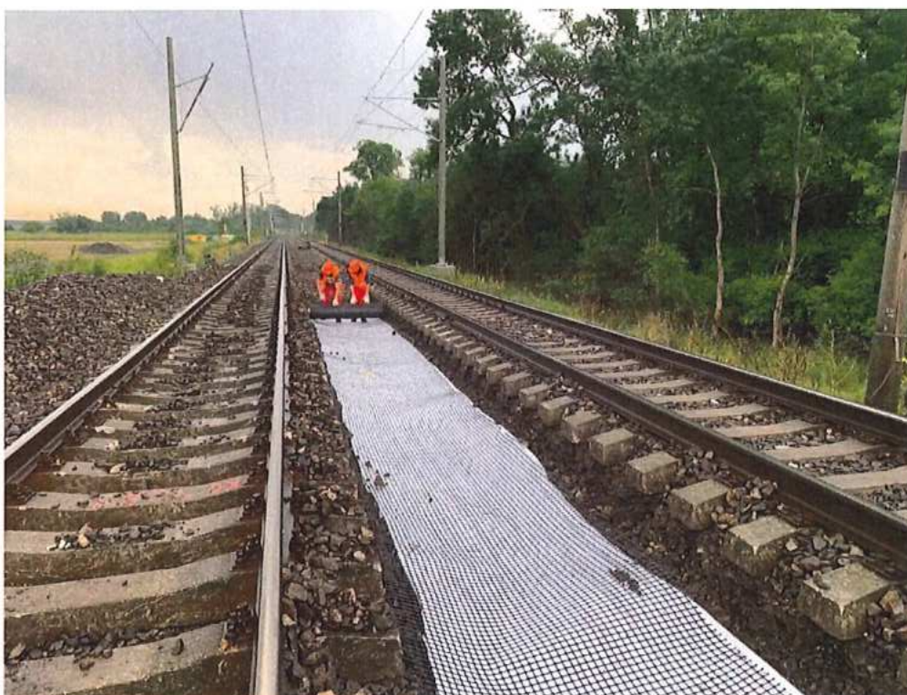
S-prepojenie – po zhutnení v osi osadenie geotextílie a geomreže Tenzar
