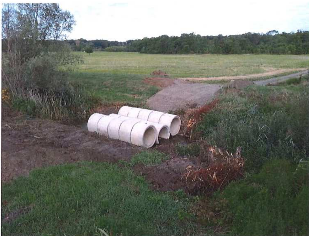
Zatrubnenie kanála 73,210, koľ.č. 1 s úpravou hrádze pre zriadenie dočasnej komunikácie na stavbu
